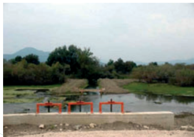
Compuertas para regular las entradas de agua dulce procedentes del río Louros
