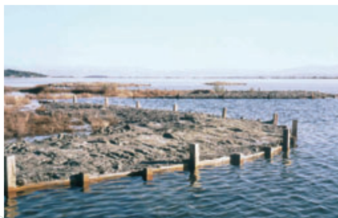
Empalizada para detener la erosión en el islote “Imiselinos” del lago Tsoukalio
