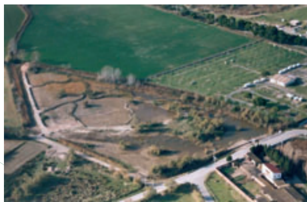
Humedales de depuración
