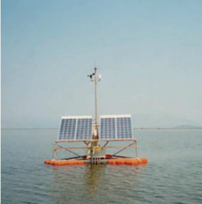
Estación automática de toma de muestras de parámetros físico-químicos en la laguna de Tsoukalio. Provee información fundamental para determinar la calidad del agua de las lagunas y del río Louros
