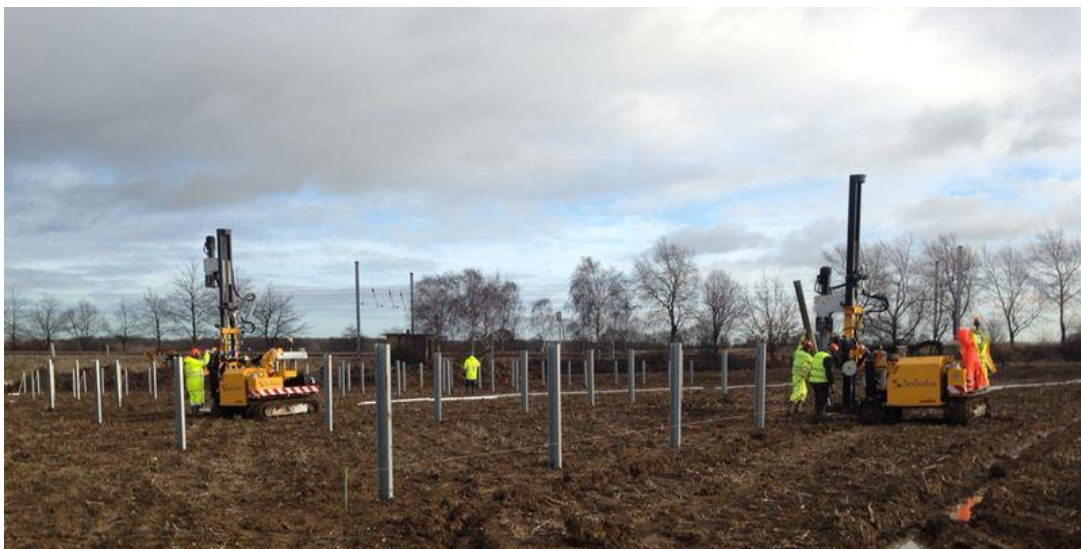
No contaminación del suelo. Sin uso de hormigón: fijación por hincado de perfiles de acero
