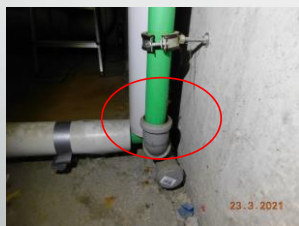
Entlastungsleitung des SV in die Entwässerung eingeführt
