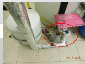
Entlastungsleitung des SV in die Entwässerung eingeführt
