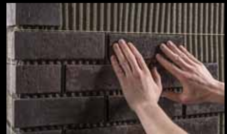
Lepení pásků s pomocí šňůry, pásek je zatlačen do vrstvy lepidla.
