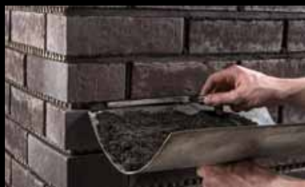
Spárování s použitím ocelové špachtle a plechového žlabu.
