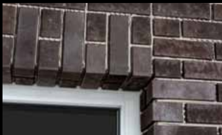
Správně použití rohových tvarovek pro řešení okenního ostění.
