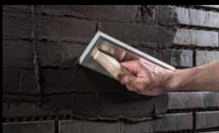
Při celoplošném spárování je spárovací hmota nanášena diagonálně gumovou stěrkou.
