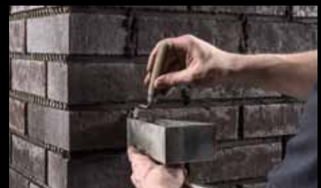
Svislé spáry jsou plněny krátkou špachtlí ze speciální nádoby se spárovací hmotou.
