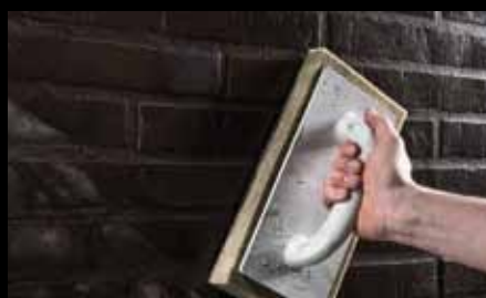
Přebytečná spárovací hmota je odstraněna diagonálním smýváním hladítkem s pěnovou hmotou.
