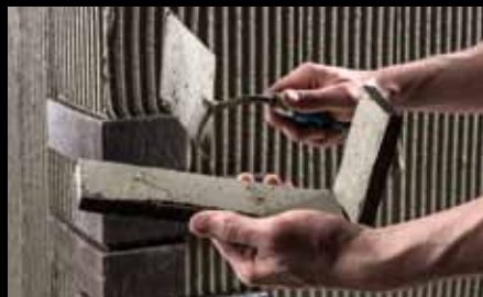
Lepení rohové tvarovky postupem Butterfloating.
