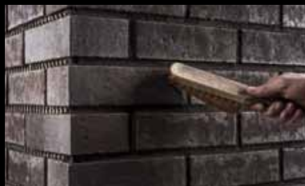
Očištění vyspárované plochy od zbytků spárovací hmoty.
