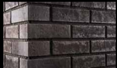
Vyspárovaný fasádní obklad.
