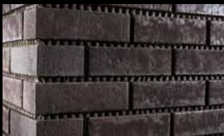
Hotová položená plocha, po předepsaném čase je možné začít spárovat.
