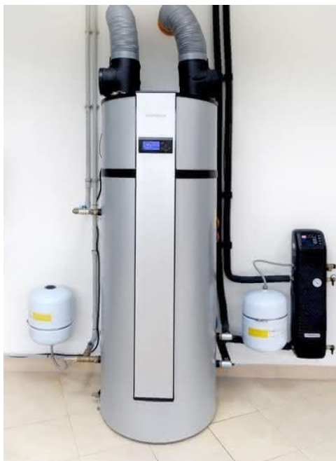
Rys. 4. Przykładowa mała pompa ciepła powietrze-woda do przygotowania c.w.u. [10]
