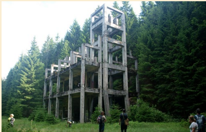
Důlní závod Přebuz, železobetonový skelet Hlavní jámy
