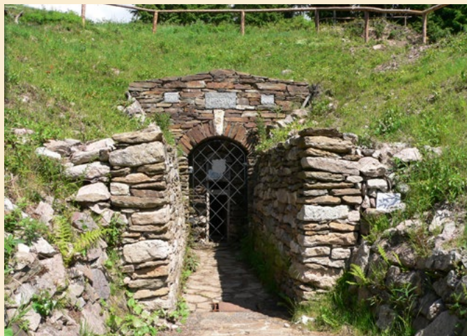
Hřebečná, obnovený portál štoly Kryštof
