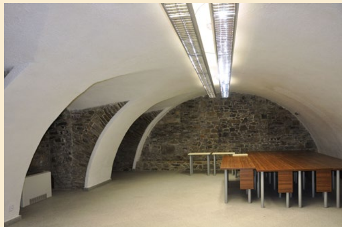
Ostrov, suterén Šlikovského zámku s odkrytou strukturou zdiva
