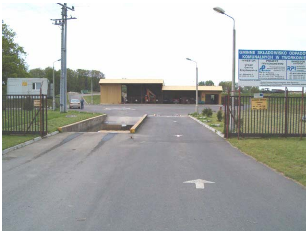
Fot. Nr 9. Brama wjazdowa składowiska odpadów w Tworkowie
