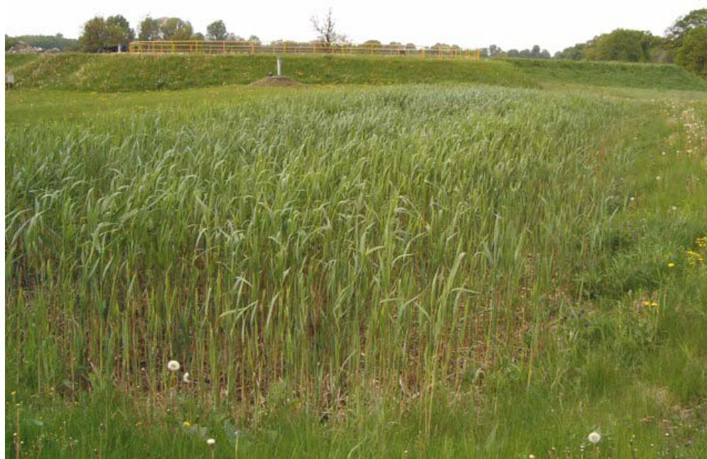
Fot. Nr 10. Podczyszczalnia hydrobotaniczna odcieków ze składowiska
