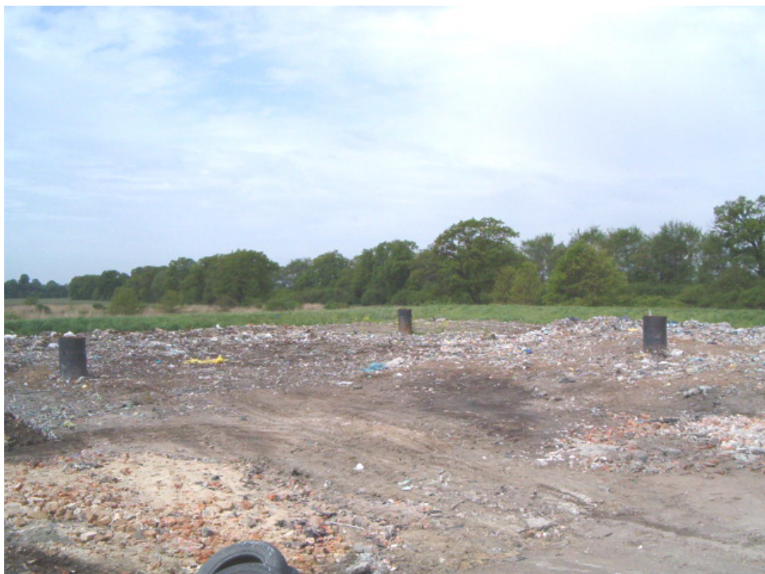
Fot. nr 17. Widok na kwaterę nr 2 składowania odpadów.
