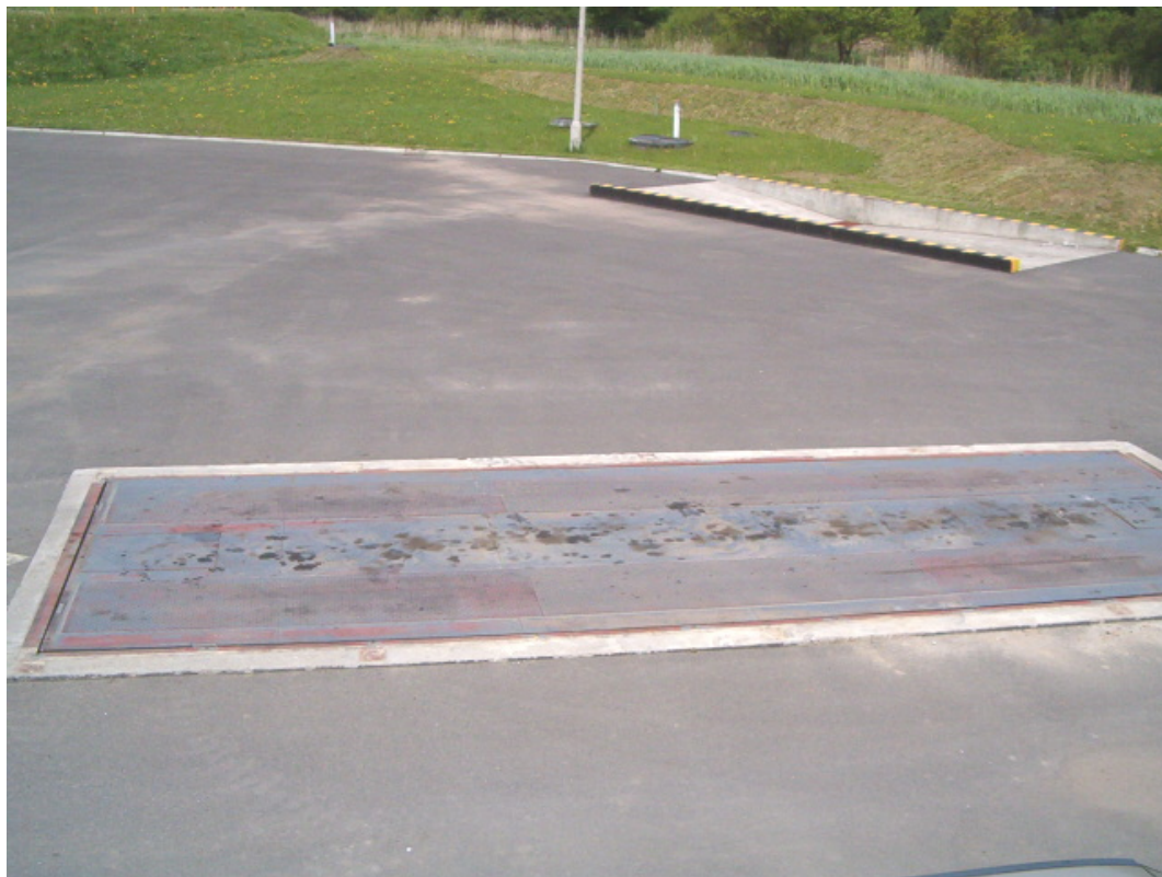
Fot. nr 13. Platforma elektronicznej wagi samochodowej do ważenia odpadów.
