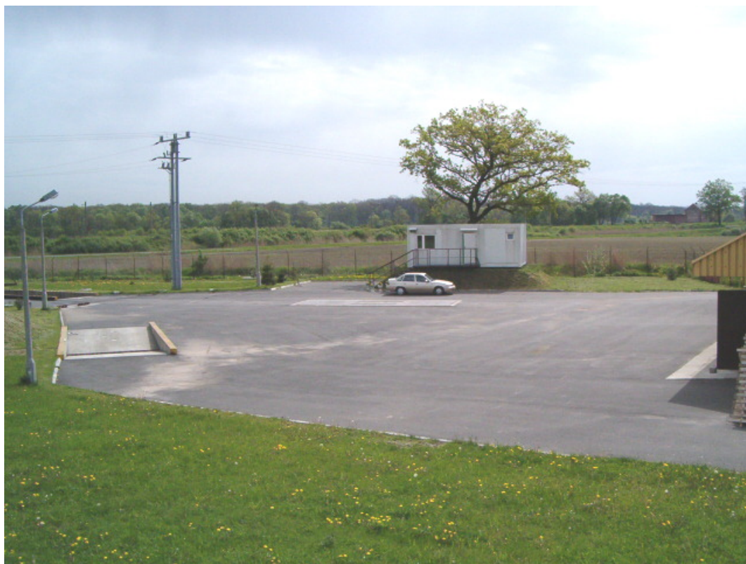
Fot. nr 15. Widok na plac manewrowy składowiska odpadów.
