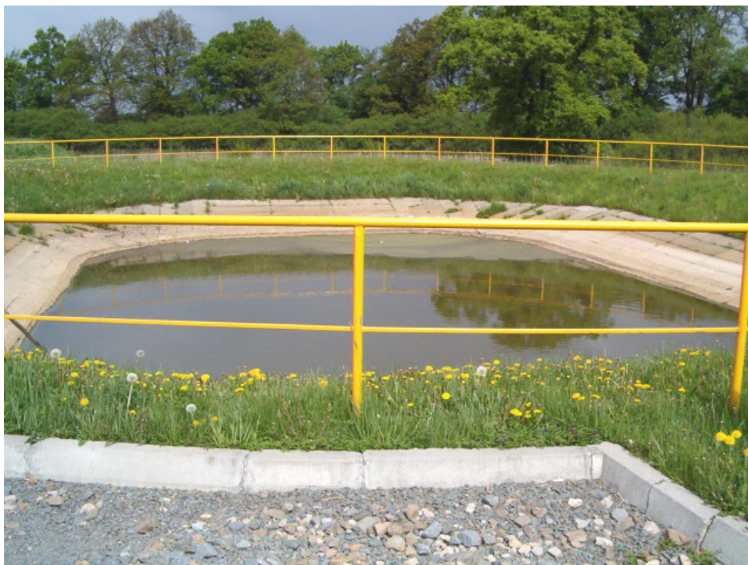
Fot. nr 16. Zbiornik na odcieki ze składowiska
