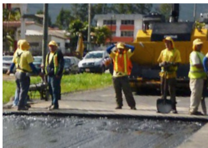
Figura 12. Preparación de paredes verticales en la junta Fuente: LanammeUCR
