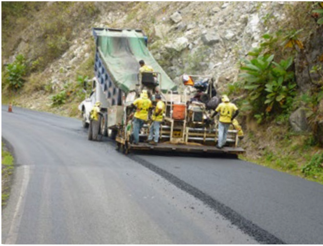
Figura 9. Colocación de capa asfáltica con pavimentadora Fuente: LanammeUCR
