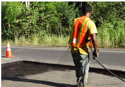
Figura 13. Riego de liga en juntas Fuente: LanammeUCR
