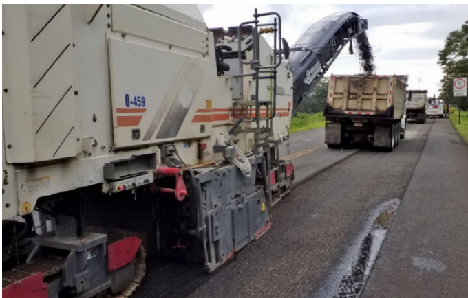
Figura 3. Perfilado de capa existente Fuente: LanammeUCR
