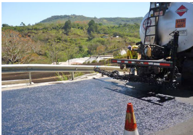
Figura 6. Riego de liga uniforme sobre la superficie
