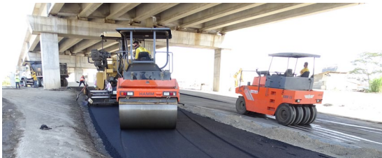
Figura 11. Proceso de compactación Fuente: LanammeUCR
