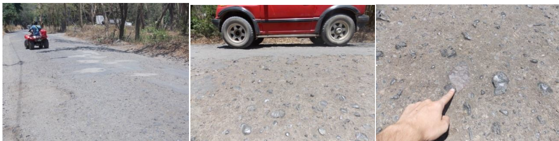
Figura 1. Camino con superficie de ruedo estabilizada con emulsión de rompimiento lento. (Condición superficial aproximadamente 1.5 años después de construcción)
