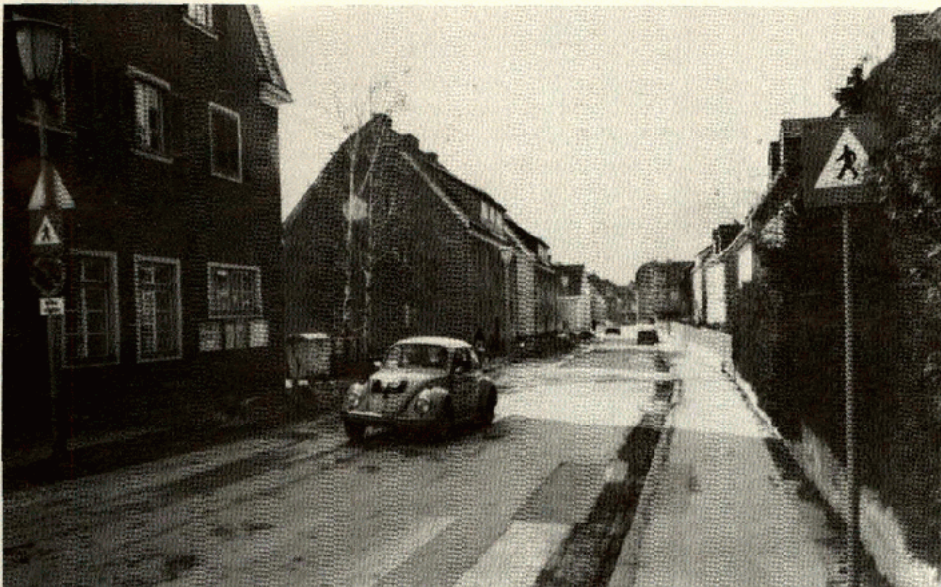
Die Grimmingasse wird gründlich saniert.
