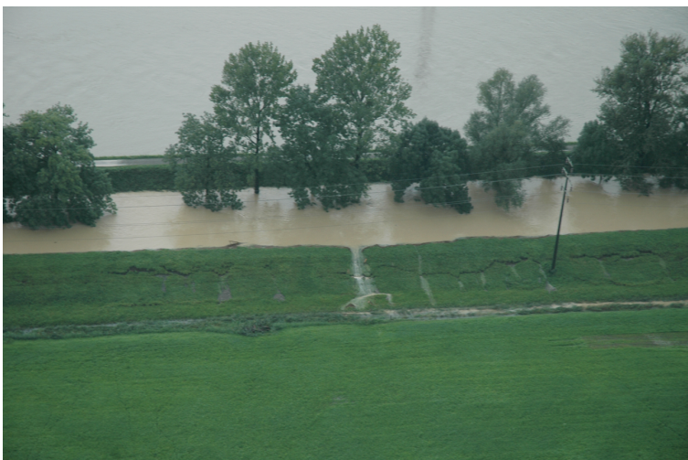
Abb. 3: Beim Damm des Rechten Hintergrabens sind die beiden Schadensbilder «Überströmen des Damms» und «Durchsickerung Damm mit Materialausschwemmung» gut sichtbar.
