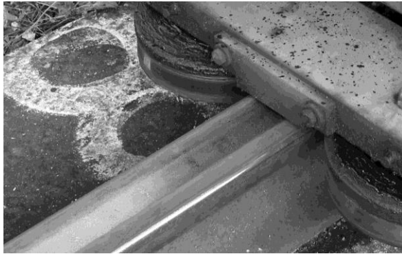
Abbildung 9. Eingelaufene Kranschiene
