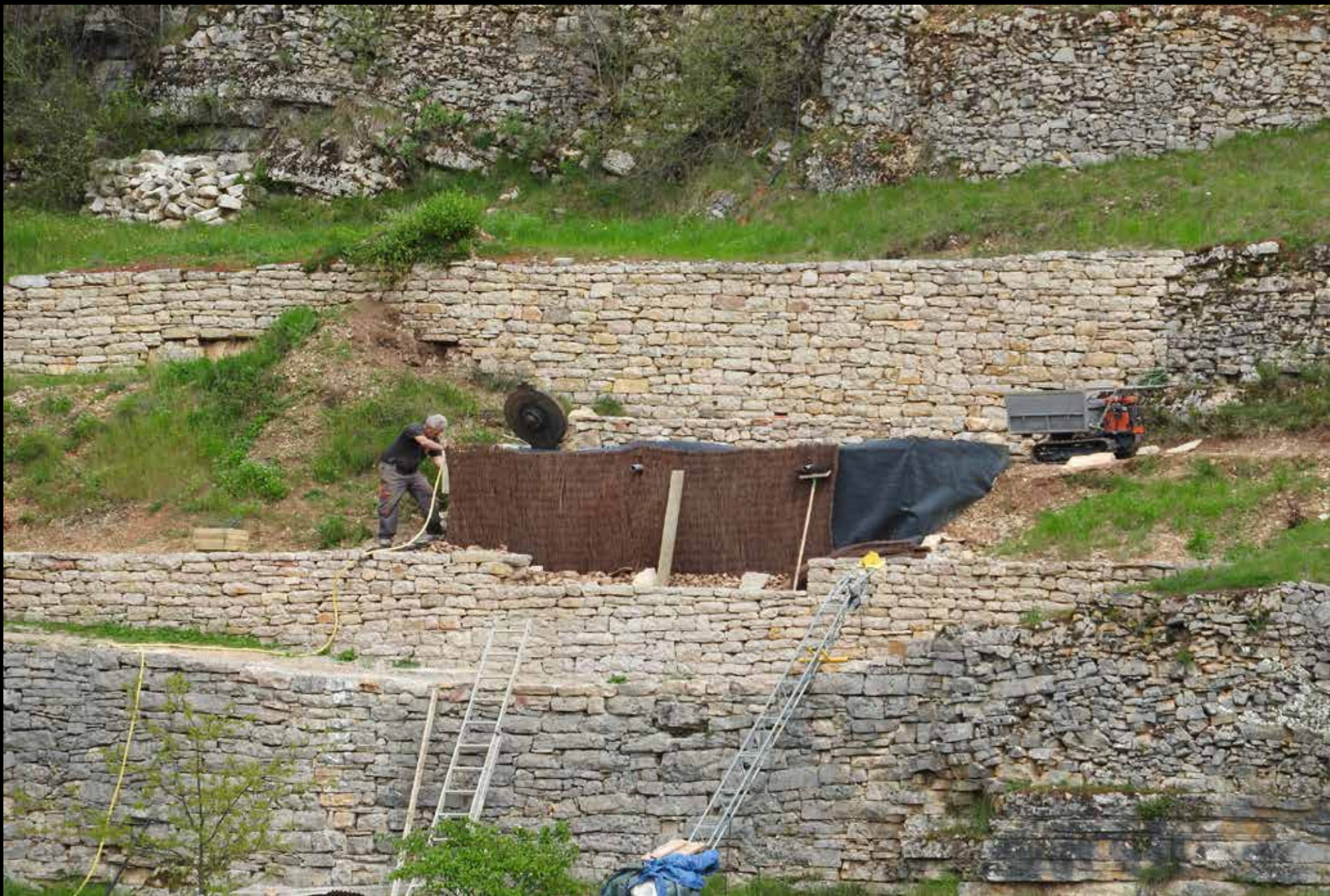
Gorges du Tarn, murs en pierres sèches à Hauterives © UDAP de la Lozère
