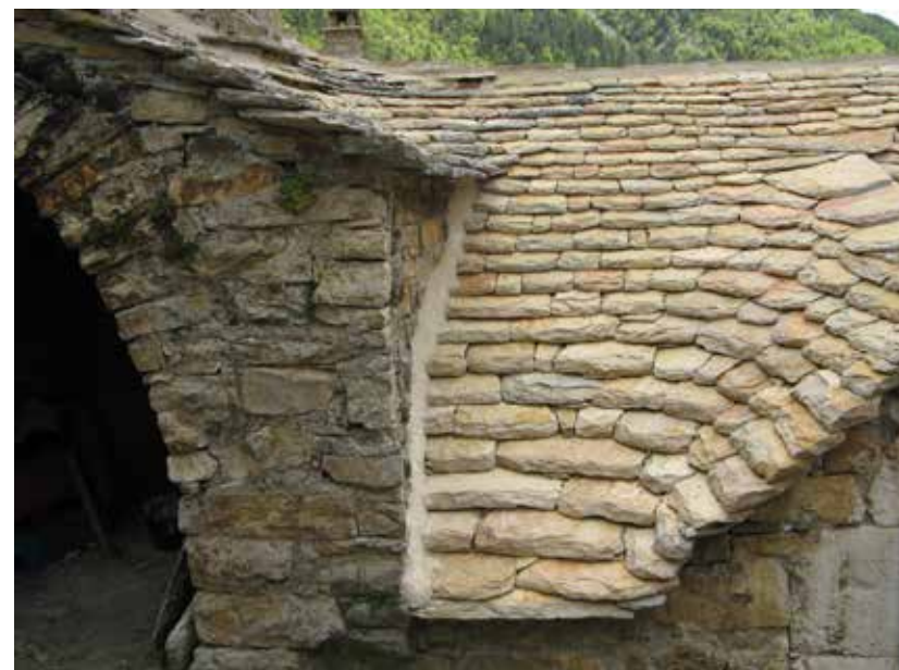
Gorges du Tarn, Hauterives, noue tournante en lauze calcaire © UDAP de la Lozère
