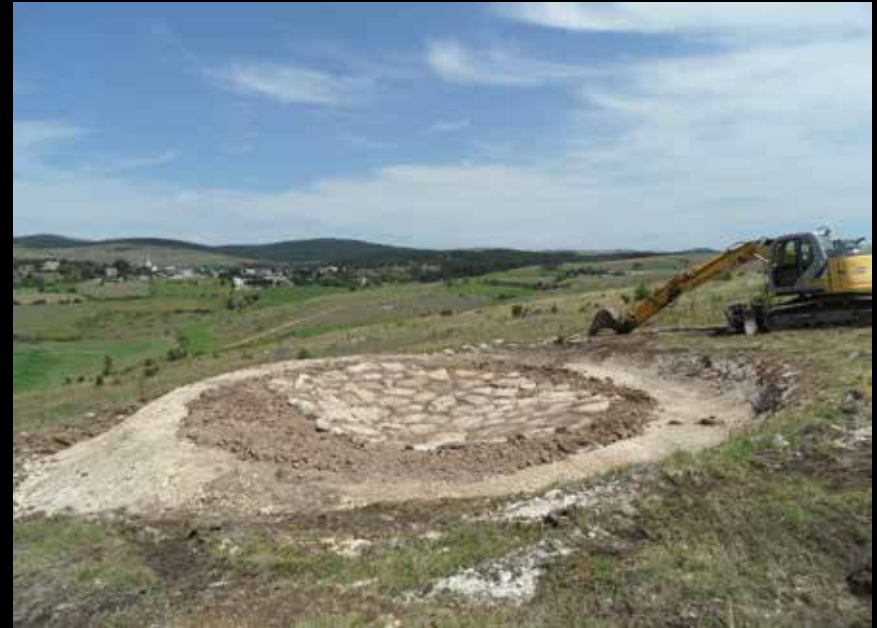
Causse Méjean, Mas-Saint-Chély, lavogne en cours de construction © FDC de Lozère
