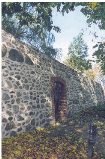
An der Stadtmauer
