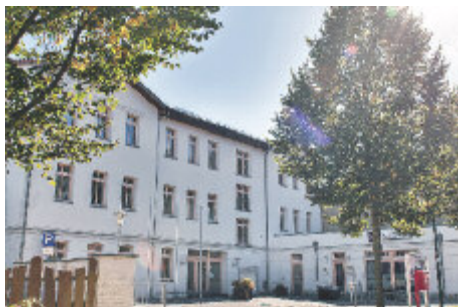
Das Amtsgebäude des Amtes Falkenberg-Höhe und das Gemeindezentrum Falkenberg
