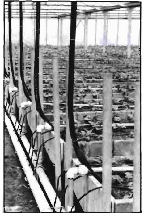
Joven plantación de gerbera. Banqueta con la instalación del riego y la calefacción de suelo con tubo coarugado
