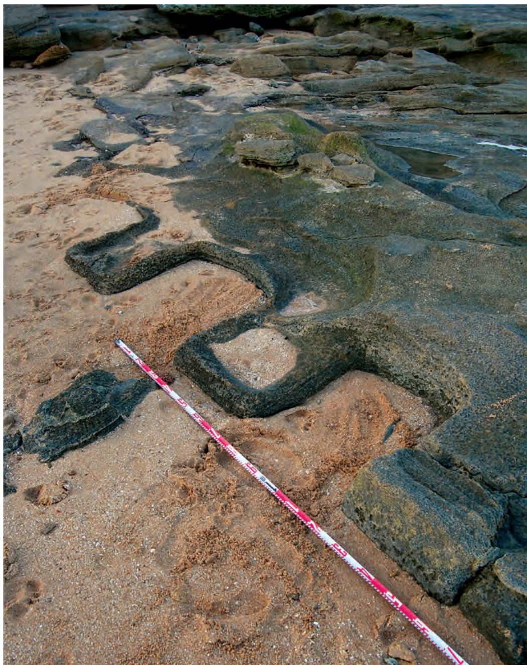
Figura 6.- Entalles para la colocación de vigas de madera u otras estructuras lógicas sobre la cubierta del vivero del Cabo Trafalgar (septiembre de 2010).
