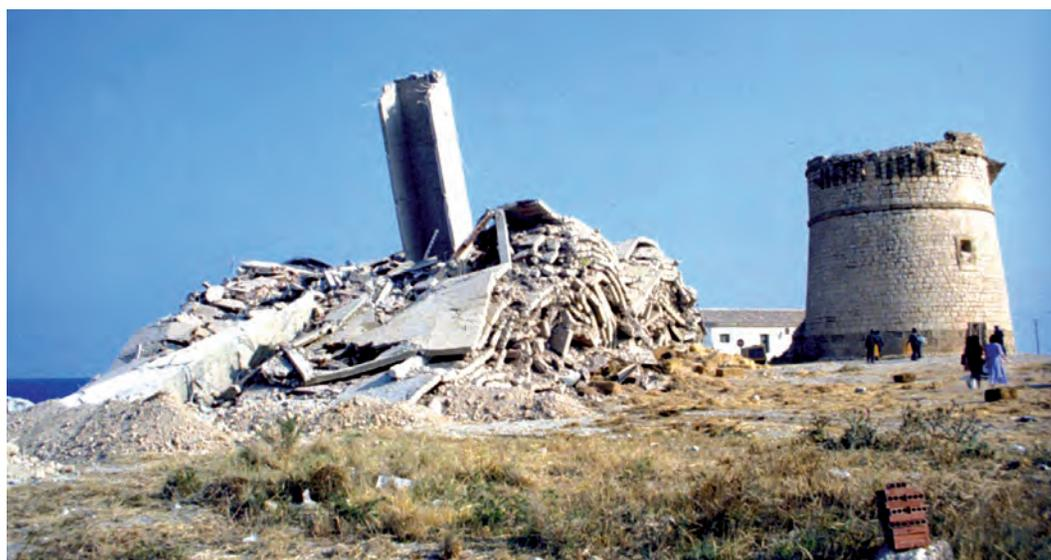
Figura 9.- Demolición por voladura controlada de la estructura de la torre de apartamentos, en 1987 (Volconsa).
