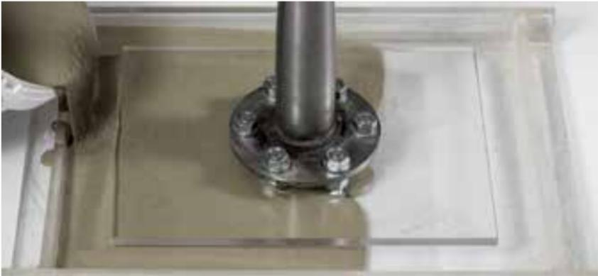
Unmittelbar nach dem Anmischen wird der Vergussbeton oder Vergussmörtel eingebaut. Um Lufteinschlüsse zu vermeiden wird nur von einer Seite aus kontinuierlich eingefüllt. Der Gießvorgang soll von der längeren Seite erfolgen. Durch Stochern mit einer Drahtschlinge, kann der Fließvorgang unterstützt werden.
