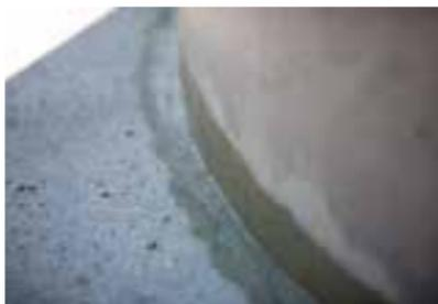
**Emcekrete MFT wird speziell zum Verfüllen von Segmentfugen im Fertigteilbau eingesetzt.**
