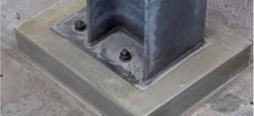
Vergussbetone und Vergussmörtel bestehen aus einem trockenen Gemisch aus Zement, mineralischer Gesteinskörnung und ggf. Betonzusatzmitteln und/oder Betonzusatzstoffen. Sie werden werkmäßig hergestellt, trocken und witterungsgeschützt gelagert.
