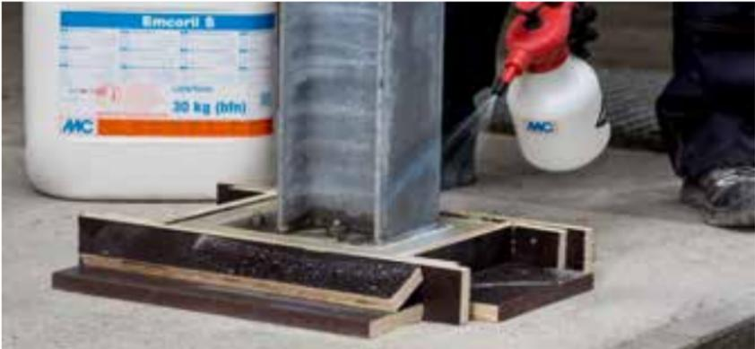
Der Abbinde- bzw. Erhärtungsprozess von Vergussbetonen und Vergussmörteln ist je nach Einbaustärke mit einer starken Wärmeentwicklung verbunden. Einer zu raschen Austrocknung des Materials (Rissgefahr!) ist durch geeignete Maßnahmen rechtzeitig gegenzusteuern. Auf die angetrocknete, mattfeuchte Oberfläche wird Emcoril Protect M lite aufgebracht.
