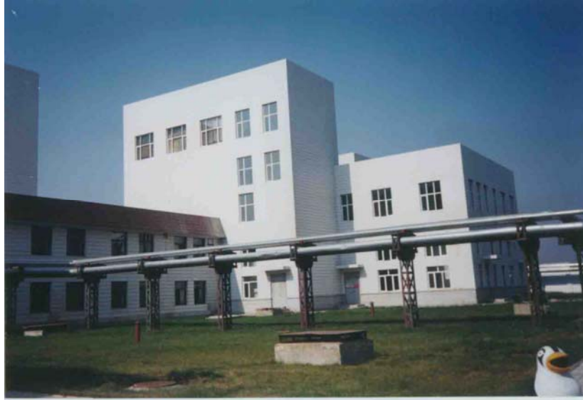
图7 中药二厂污水处理站外貌
