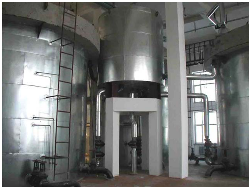
图8 完全混合式厌氧反应池
