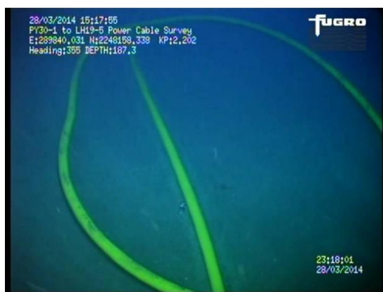
图 3.2-1c 脐带缆盘圈
