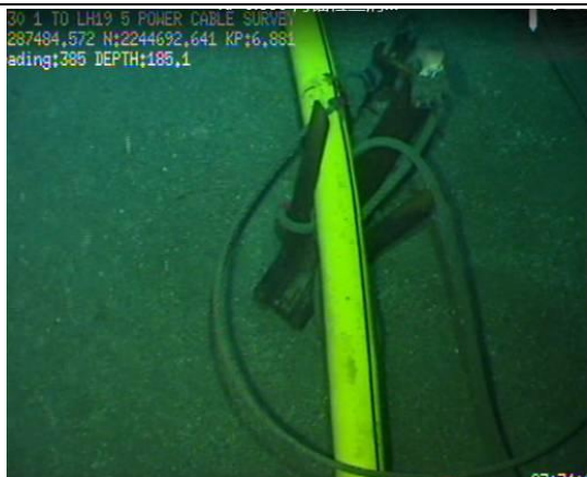
图 3.2-1a 脐带缆有废弃海锚
