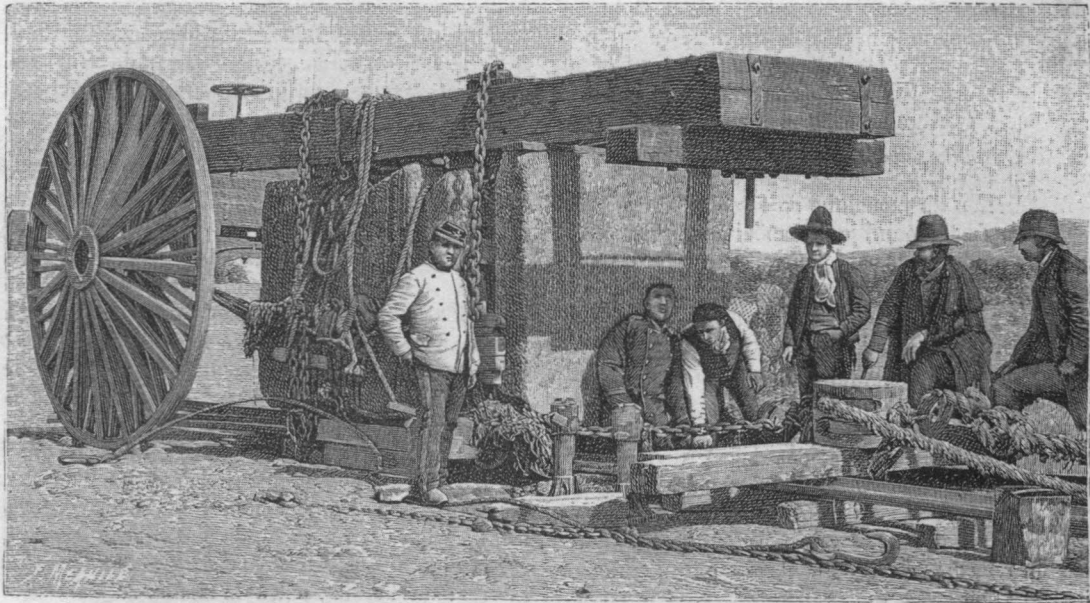
Fig. 2. — Le monument de la Déesse de l'eau , fixé au chariot de transport.
