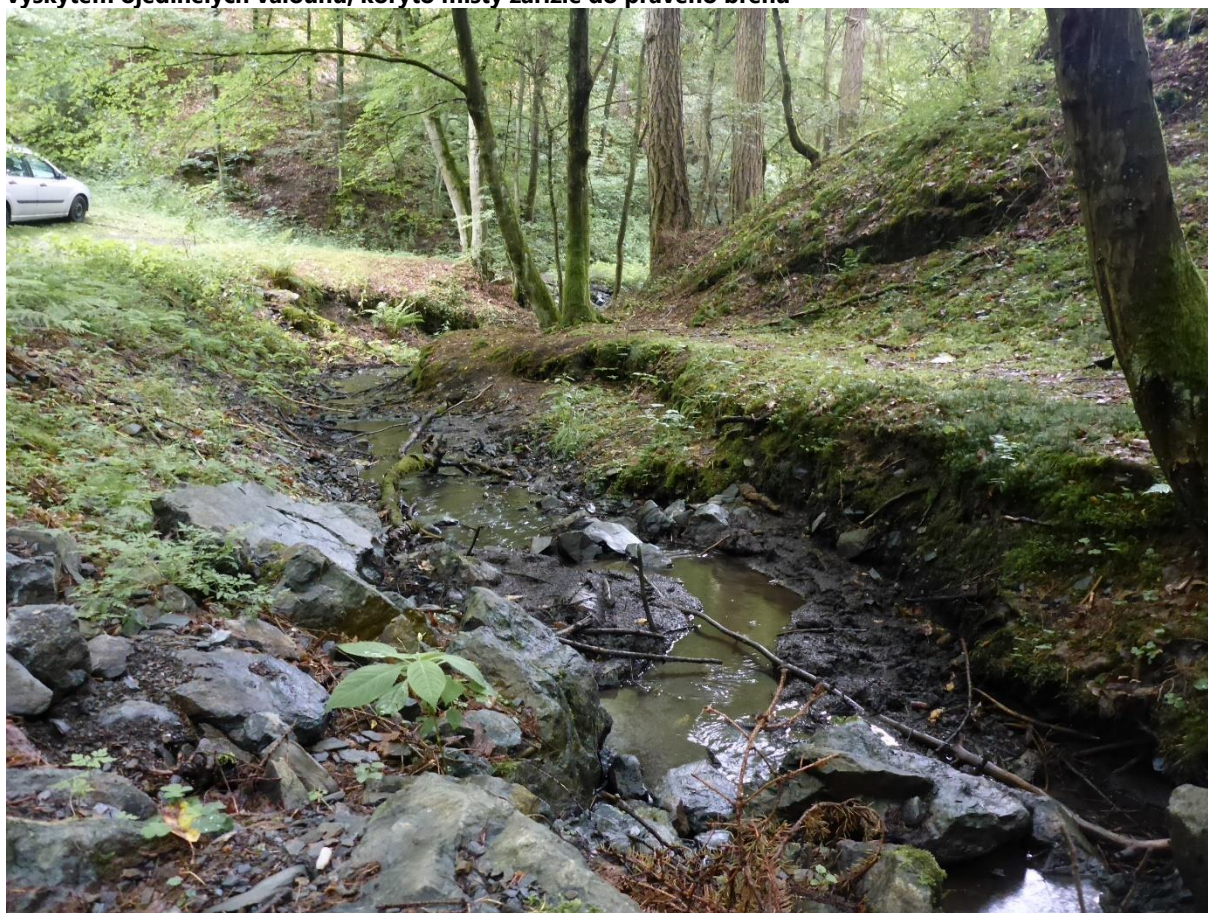
Obrázek 10.63: ř. km 0,241 - pohled po proudu Křížového potoka s mělkým korytem s kamenitým dnem a výskytem ojedinělých valounů, koryto místy zařízlé do pravého břehu
