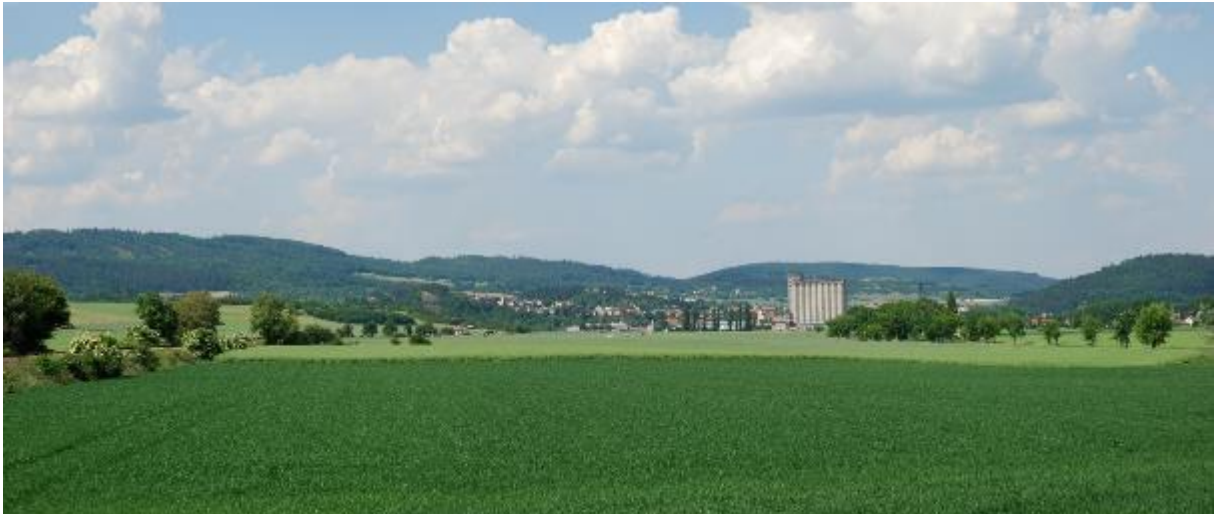
Obrázek 10.39: Hostomická kotlina. Pohled od Bavoryně směrem ke zdicím na nejvýraznější dominantu území Hořovicka – obilné silo.
