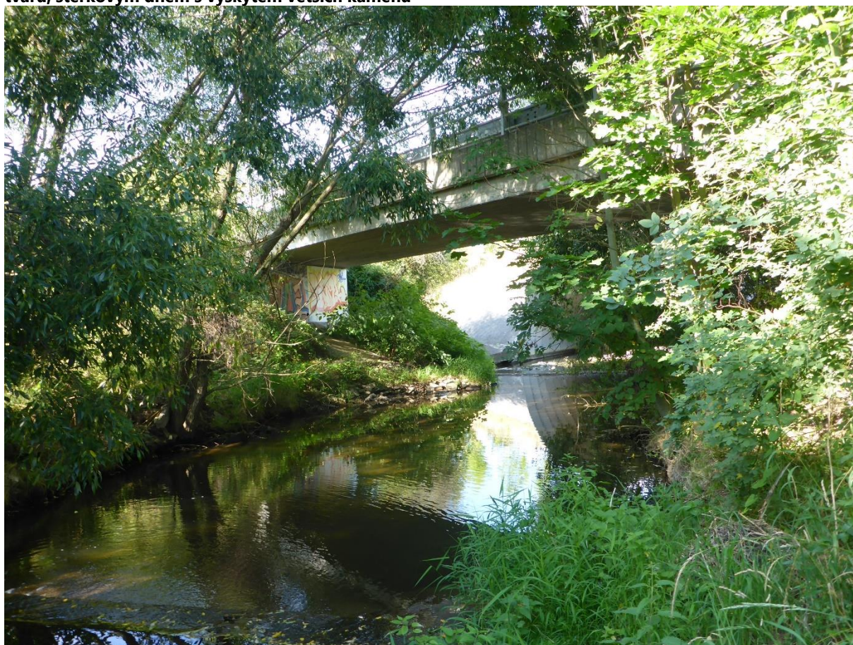
Obrázek 10.77: ř. km 0,515 - pohled po proudu Stroupínského potoka se širokým korytem lichoběžníkového tvaru, stěrkovým dnem s výskytem větších kamenů
