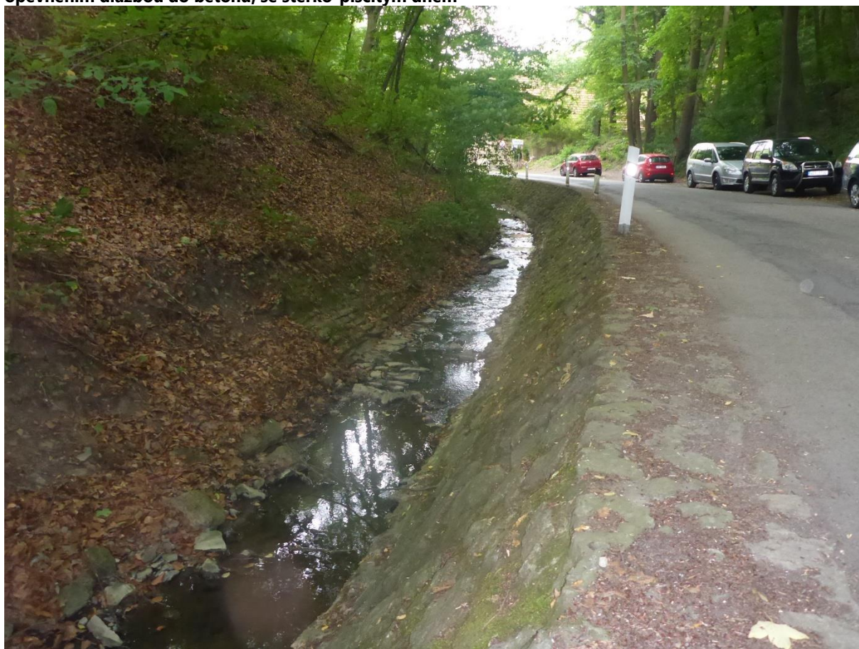
Obrázek 10.44: km 1,550 - pohled na lichoběžníkové koryto Budňanského potoka s pravostranným opevněním dlažbou do betonu, se šěrko-písčítým dnem
