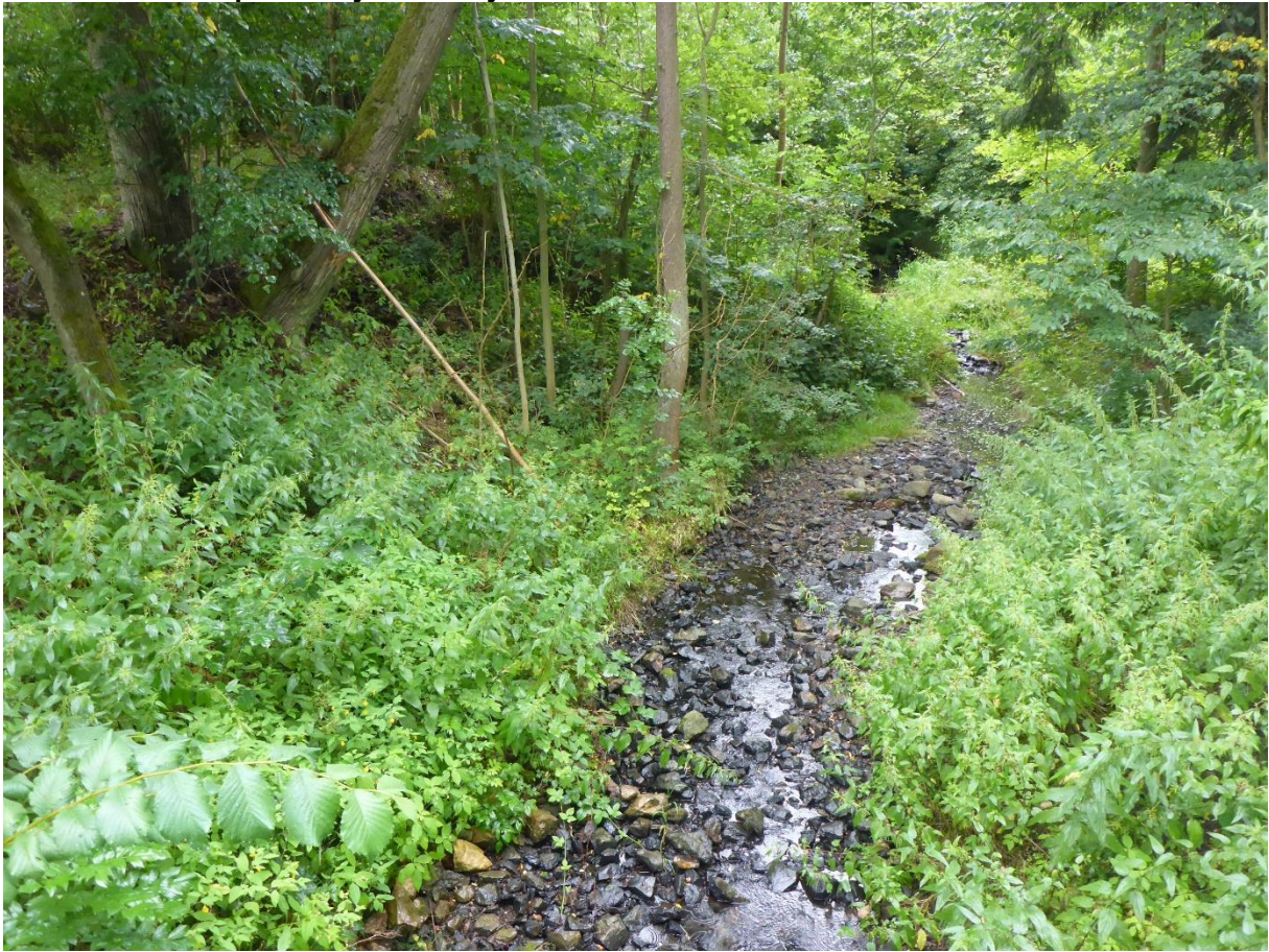
Obrázek 10.69: ř. km 7,380 - pohled po proudu Úpořského potoka s kamenitým dnem, koryta lichoběžníkovitého profilu s vyššími břehy
