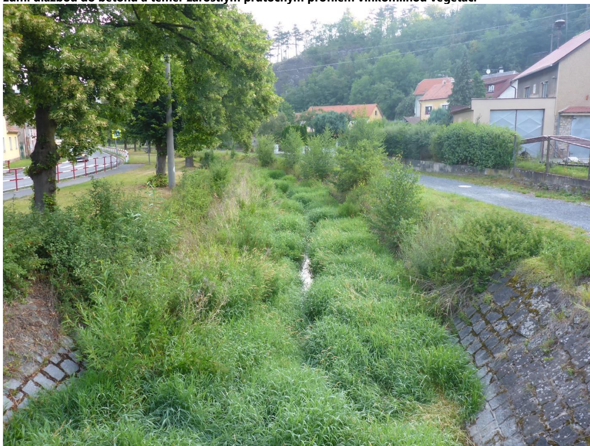
Obrázek 10.82: ř. km 0,960 - pohled po proudu Svinařského potoka s korytem v intravilánu s opevněnými zdmi dlažbou do betonu a téměř zarostlým průtočným profilem vlhkomilnou vegetací
