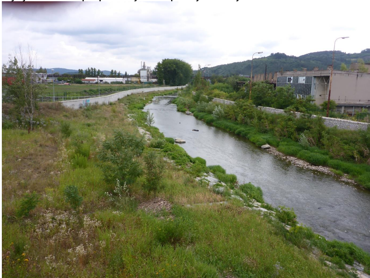
Obrázek 10.78: ř. km 4,950 - pohled po proudu Litávky s rozšířeným korytem v místě silničního mostu, jinak s výskytem nábrežních protipovodňových zdí a opevněným nárazovým břehem kamennou rovnaninou
