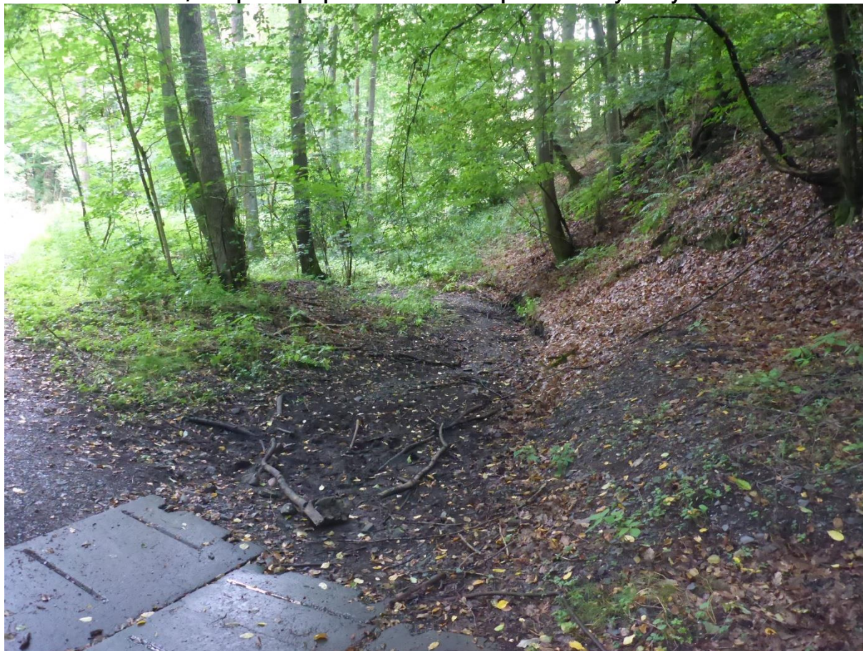
Obrázek 10.60: ř. km 0,650 - pohled po proudu Žlubineckého potoka s mělkým korytem
