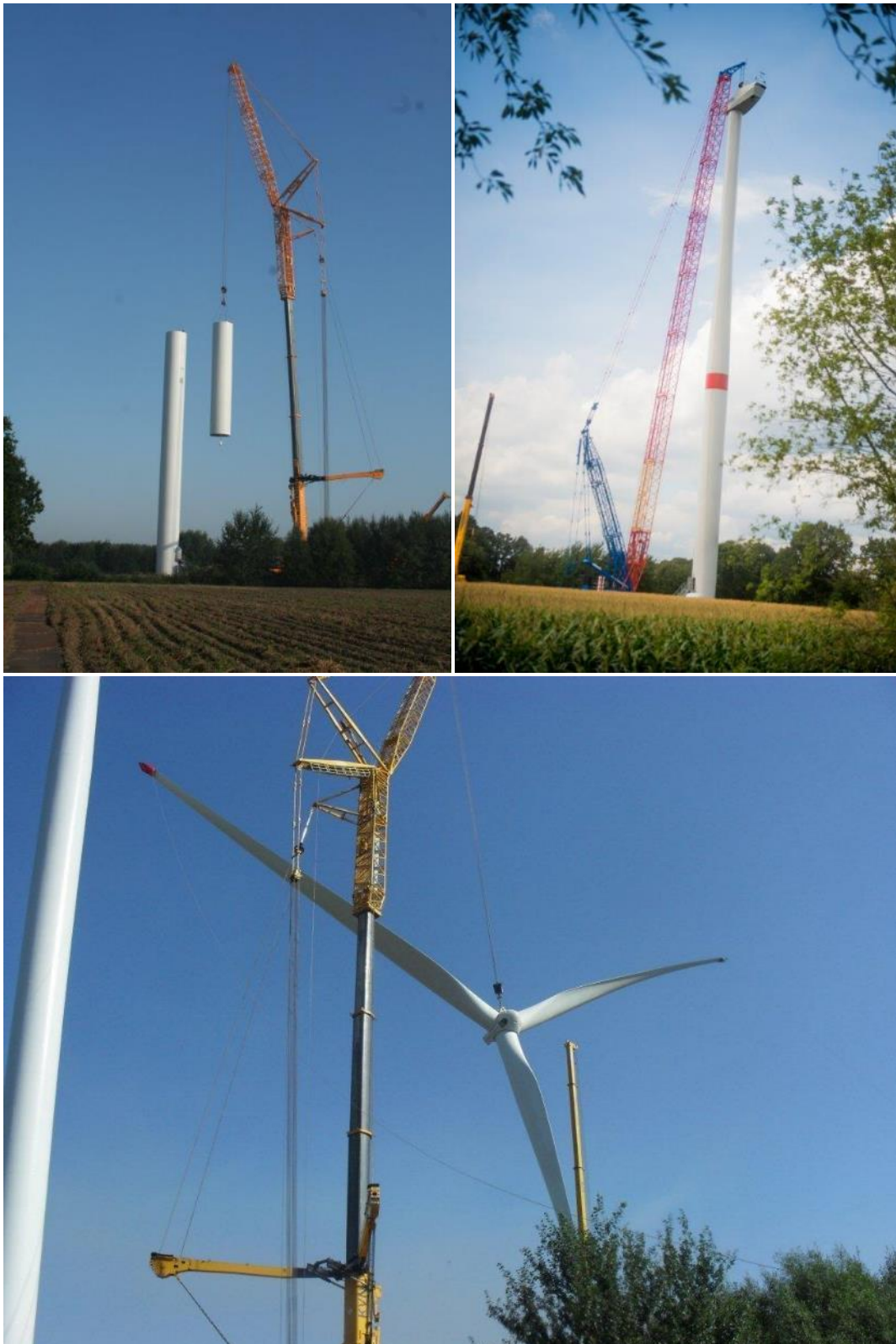
Illustratie 3.5: Montage windturbines enerzijds met telescoopkraan, anderzijds met opbouwkraan
