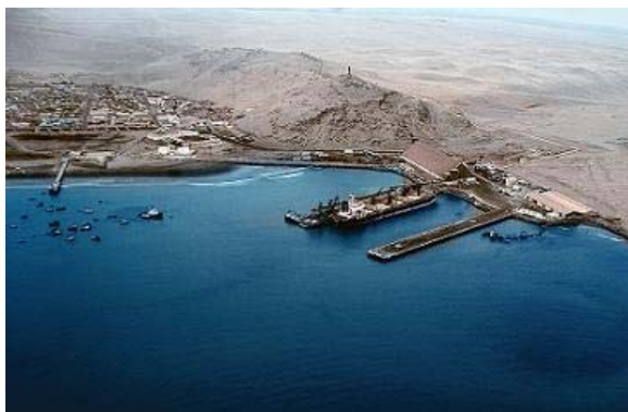
Figura 8.1.- Vista del puerto de Salaverry donde se aprecia el arenamiento en la zona sur. Fuente: ENAPU - Salaverry
