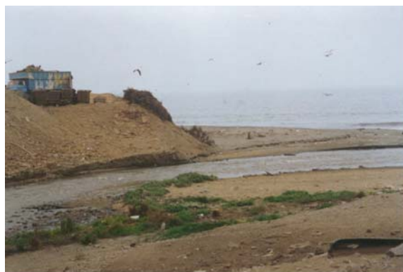
Figura 3.7.- Desmonte llevado por camiones al litoral de Callao con la finalidad de efectuar un relleno para luego ser ocupado por viviendas. (Foto G. Sánchez)
