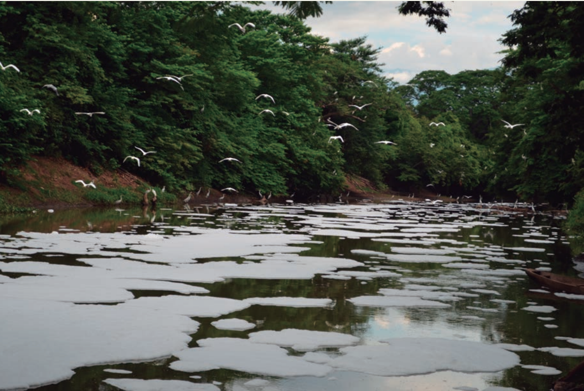
Laguna de oxidación en el río Cesar. En este tipo de sistemas artificiales, se llevan a cabo procesos de depuración de aguas servidas, que vienen cargadas con gran cantidad de tensoactivos producto de detergentes ricos en fosfatos provenientes de la ciudad de Valledupar, departamento del Cesar.
