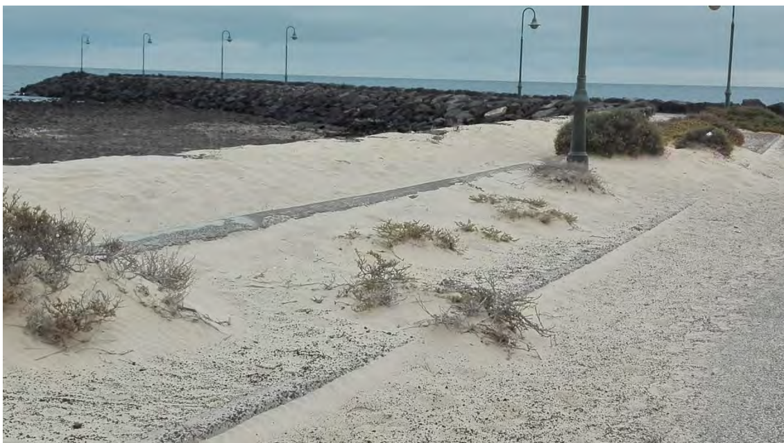
Ilustración 15: Acumulación de arena en el trasdós de la playa
