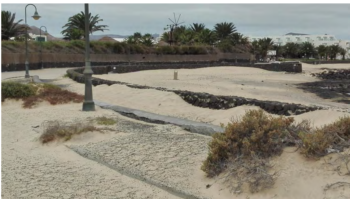
Ilustración 16: Acumulación de arena en el trasdós de la playa
