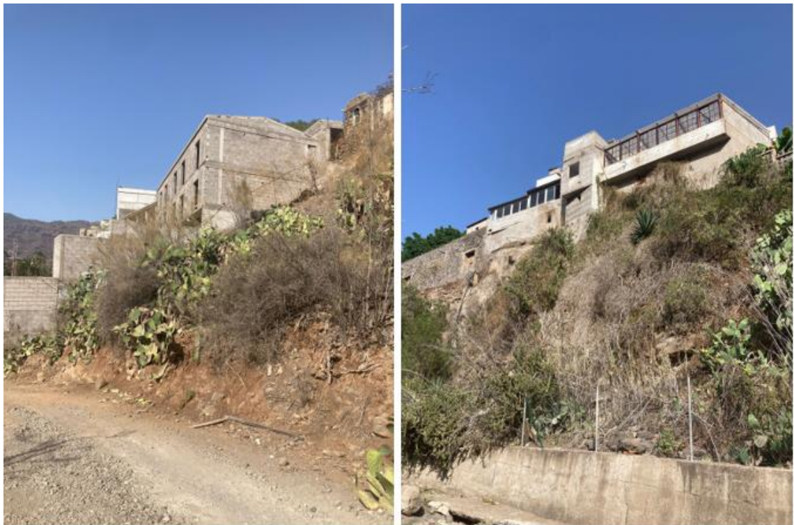
Ejemplos de los distintos estados en los que se encuentran las edificaciones presentes en el barranco. Fuente: Ayuntamiento de Mogán.
