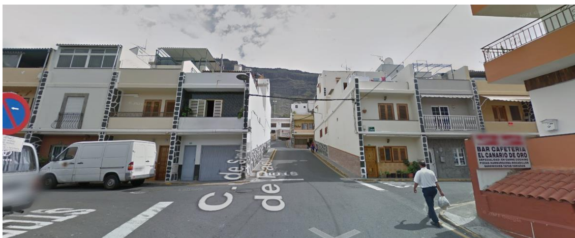
A la izquierda se visualiza la vivienda a demoler de la Calle El Drago para el ensanche de la carretera y a su derecha un ejemplo de las medianeras sin tratar y la situación del tendido eléctrico. Fuente: Google Maps.
