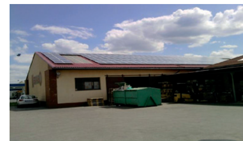
FVE provozovna firmy ve Staré Boleslavi
