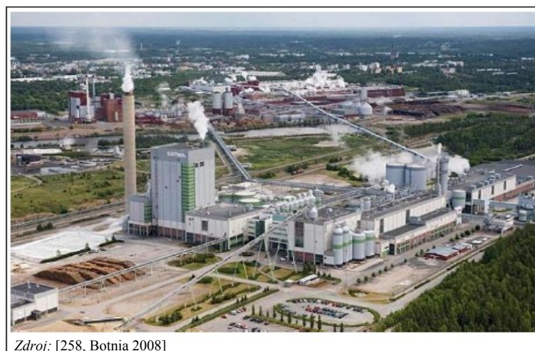
Obrázek 1.22: Letecký pohled na integrovaný závod na výrobu sulfátové buničiny, mechanické vlákniny a papíru s kotelnou a čistírnou odpadních vod
