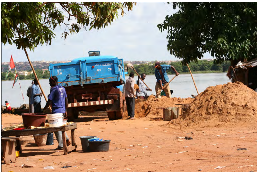
Bamako - ruční nakládka říčních písků na deponii u řeky Niger (GET s.r.o., září 2007)
