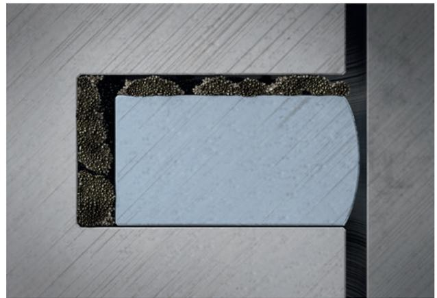
Abb. 1: Schmutzablagerung in der Ringnut
