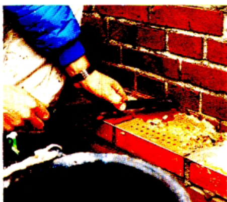
Fig. 8. Rensning og forvanding af hul til murbinder.
