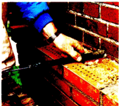
Fig. 9. Udstøbning af hul til murbinder.
