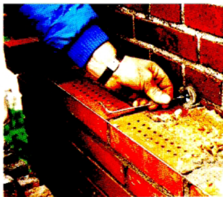
Fig. 10. Indpresning af murbinder.
