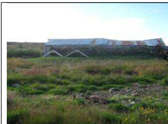
ÍS-207:003 – Steinahús, horft til norðvesturs.
