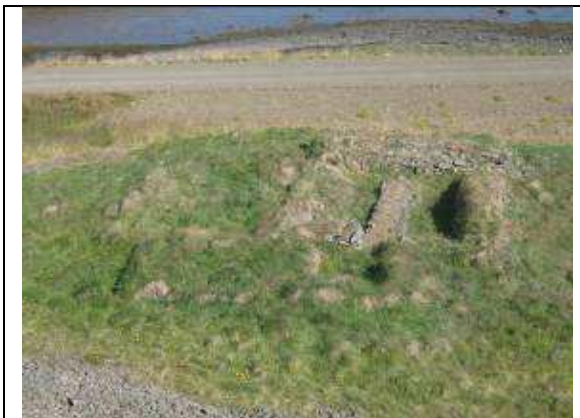
ÍS-205:017 – Fjárhúsið í Sauðhúshvammi, horft í austur.
