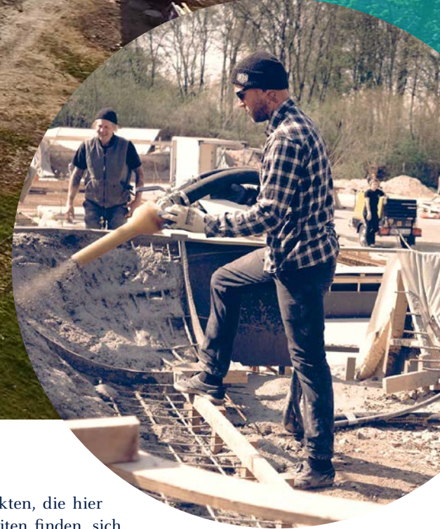
Anpacken beim Bau: individuelle Fertigung aus Beton
