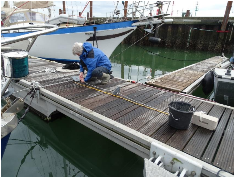
Abb. 5: Anpassen der Plattenabstände an die Wassertiefe (Hafen List)
