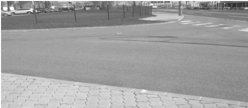
Místo nad potrubím s výskytem anomálního signálu
