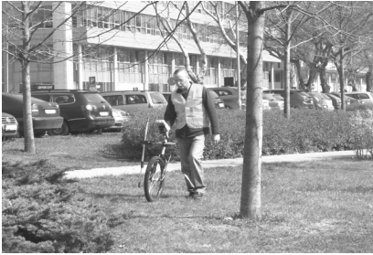
Praktické provádění inspekce potrubí uloženého v zemi
