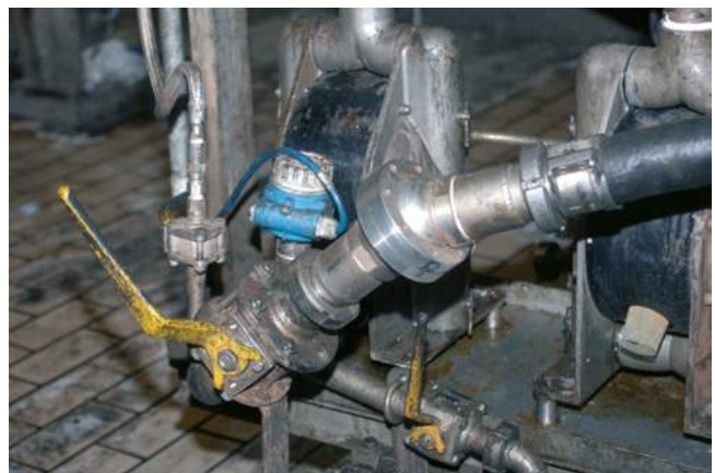
Abbildung 13b: Verlegen von Schlauchleitungen – Kugeldrehgelenk
