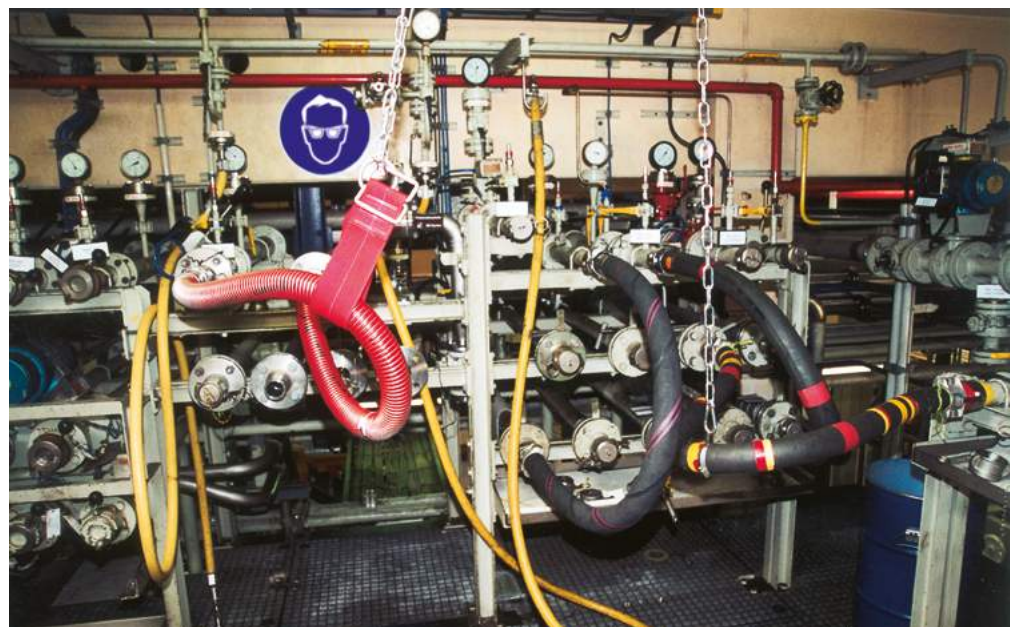
Abbildung 13c: Verlegen von Schlauchleitungen – „Schlauchbahnhof“
