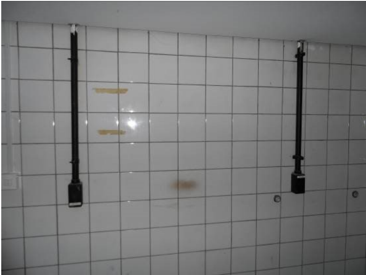
Abbildung 9-elektrische Pfeife macht Reinigung und scheinbare begünstigt die Ausbreitung von Pilzen und Bakterien.
