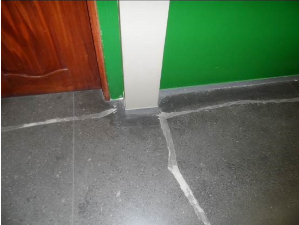
53-Risse in dieser Vermehrung von den Säulen.
