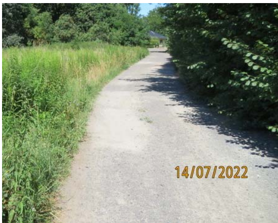
Unbefestigter teils geschotterter Weg im Bereich Koppehof
