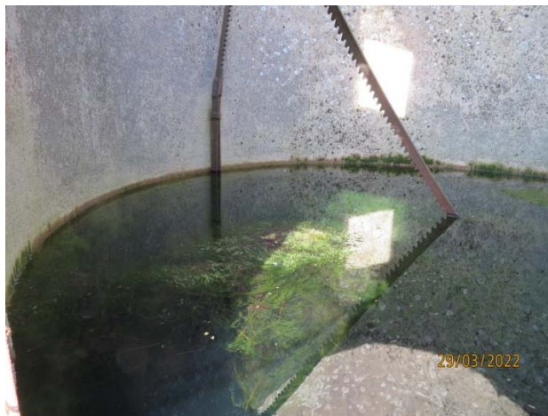
Wassergefülltes Betonsilo Koppehof SO
