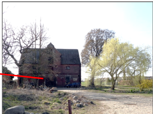
Blick von der Straße Koppehof nach West auf das denkmalgeschützte Speichergebäude Koppehof 11
