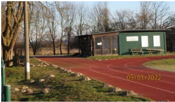
Sportfunktionsbau (Containerlösung) - versiegelt
