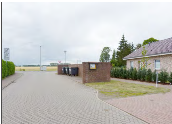
Zu den Eichen, Recyclingbehälter-Sammelplatz
