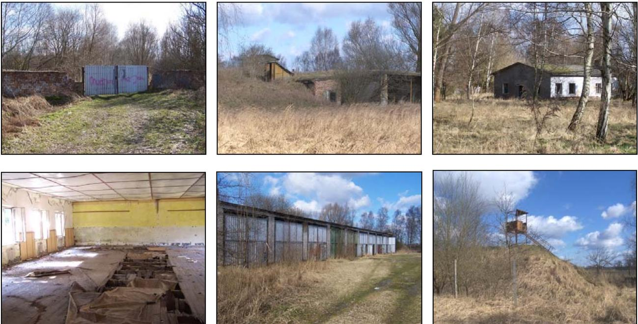
Auf Grund der früheren Nutzungen im Plangebiet befinden sich im Bereich der ehemaligen Radarstation ungenutzte Gebäude, Befestigungen und Einfriedungen. Diese baulichen Anlagen sind bei einer späteren Nutzung der betreffenden Fläche zu beseitigen. Auf Grund der früheren Nutzungen besteht hier ein Altlastenverdacht, der vertiefende Untersuchungen und entsprechende Sanierungen erforderlich macht (sh. hierzu unter U1.b) 7).
