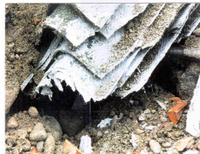
Fotografia n. 16 - Particolare di cemento Amianto smontato
