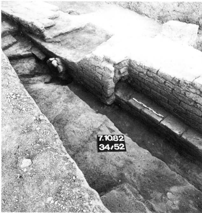
Abb. 8. Bauphasen IIIb, IVa und IVb mit Baugrube in 34/52, Blick von SW (Photo Wolfgang Bitterle)
