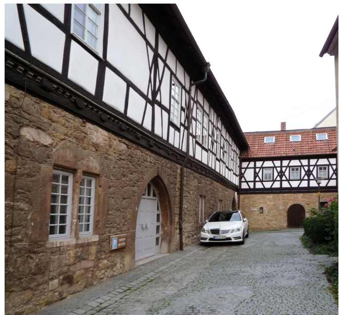
Fachwerk mit Erdgeschoss in Naturstein
