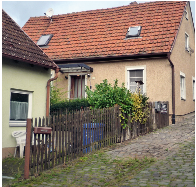
Lattenzaun als Hofabschluss
