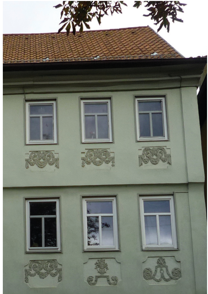
Rhythmische Fassadengliederung mit stuckierten Fensterbänke
