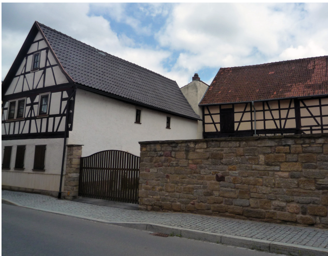
Hofabschluss mit Mauer und Hoftor
