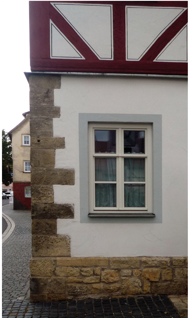
Sprossenfenster mit Putzfasche
