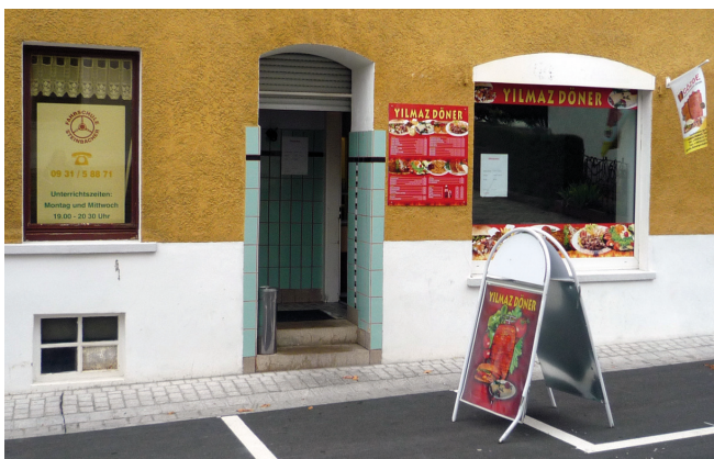
Negativbeispiel: unruhige Fassade durch nicht abgestimmte Werbelemente
