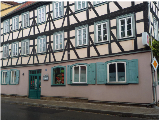
Lochfassade im Fachwerk
