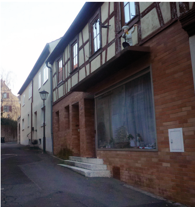
Negativbeispiel: nicht abgestimmte, unpassende Fassadengestaltung
