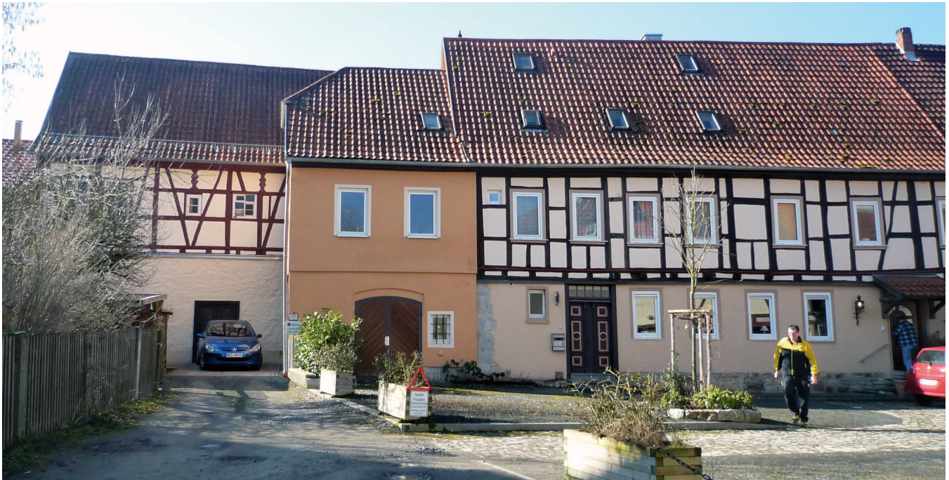
Fassaden in hellen gedeckten Farben
