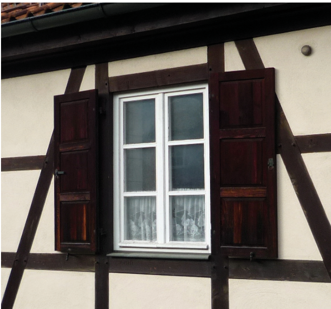
Sprossenfenster in Fachwerk
