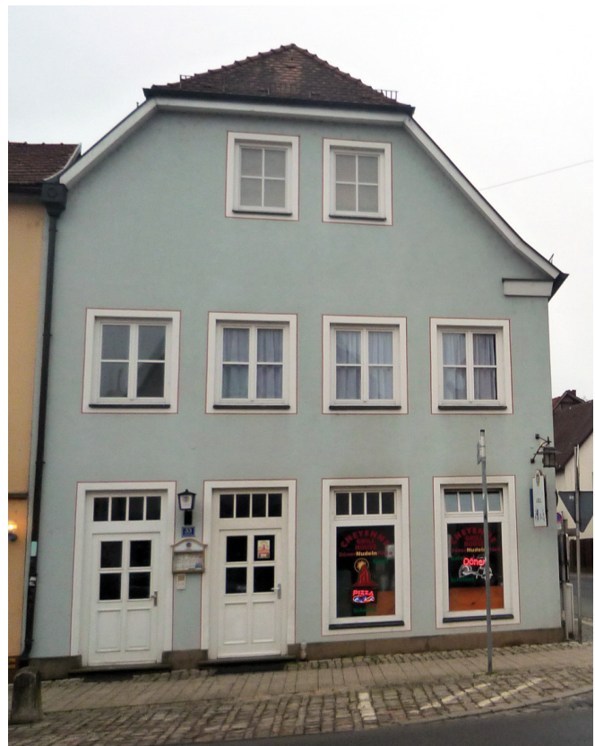
Eingänge und Schaufenster auf die Fenster abgestimmt
