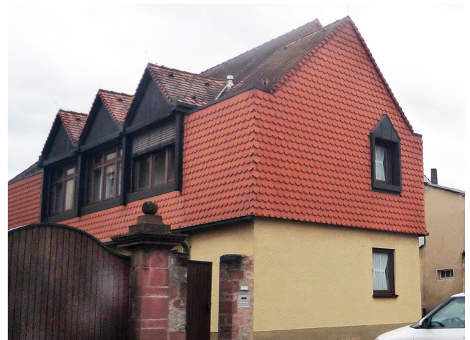
Negativbeispiel: Untypische Deckung und Dachgestaltung
