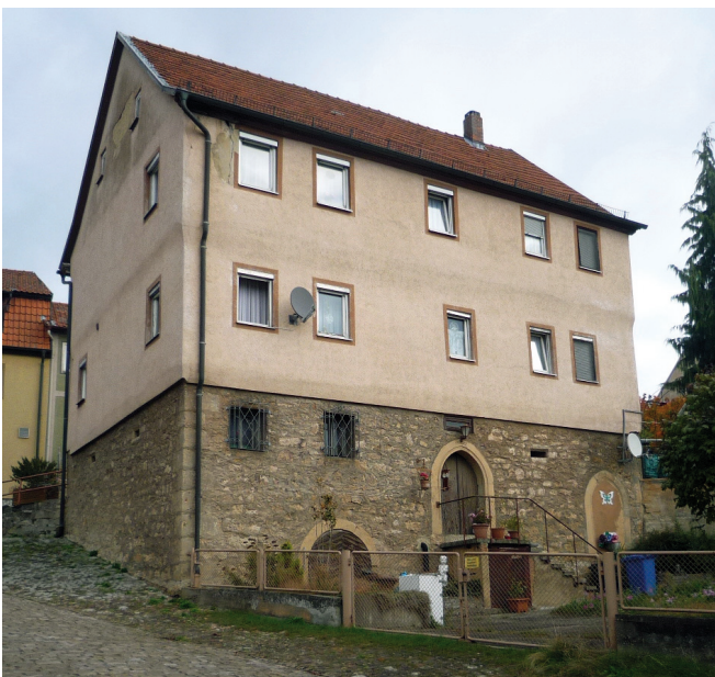
Putzfassade mit Natursteinsockel bzw. Sockelgeschoss.
