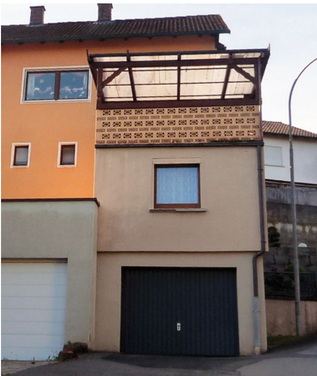
Negativbeispiel: unpassende Balkonbrüstung und Kunststoffüberdachung
