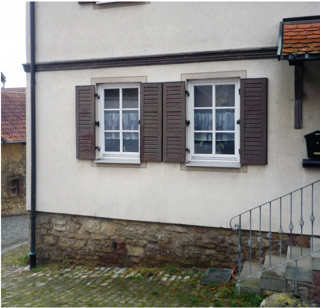
Sprossenfenster mit Fensterläden
