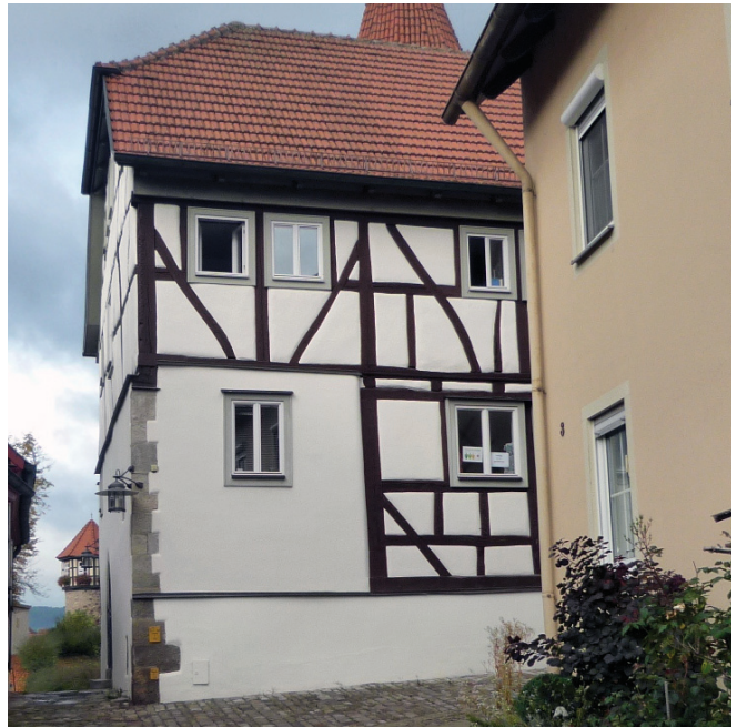
Krüppelwalm an historischem Gebäude
