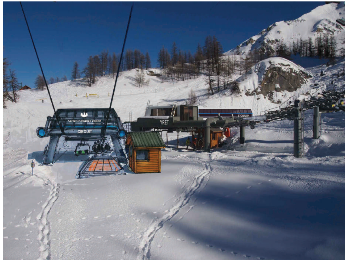
PHOTOMONTAGE INSERTION GARE AVAL G1 DEPUIS LA LIGNE AVEC GARES DU TSF DE L'YRET ET TSD DE L'EYCHAUDA EN ARRIÈRE PLAN
