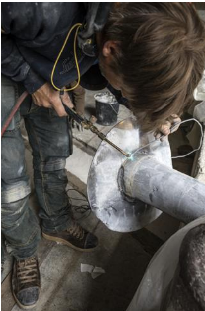
Brasure d'une gouttière d'évacuation des eaux du jardin (Abbaye du Mont-Saint-Michel)
