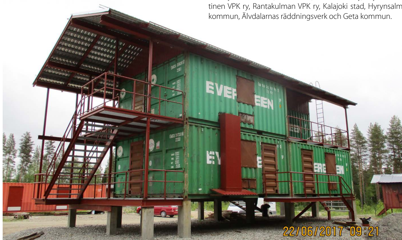
Bild 1. Räddningsverket i Kajanaland beviljades sammanlagt 39 320 euro i understöd för byggande av ett övningshus i övningsområdet 2015. Övningshuset byggdes 2015–2017 och togs i bruk i september 2017. Brandhuset används av räddningsverket i Kajanaland och militärbrandkåren vid Kajanalands brigad. Det är byggt av sju sjöcontainrar på sex meter och stålkonstruktioner på fast pelargrund. I brandhuset kan man genomföra varma och kalla rökdykningsövningar, olika redskapsklareringsövningar, övningar i arbete på hög höjd och lyft- och nedsänkingsövningar. Bild: Räddningsverket i Kajanaland
