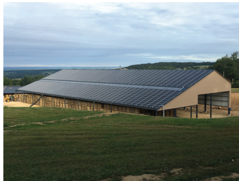
Installation photovoltaïque sur bâtiment agricole - E.Bourgy - CA 58
