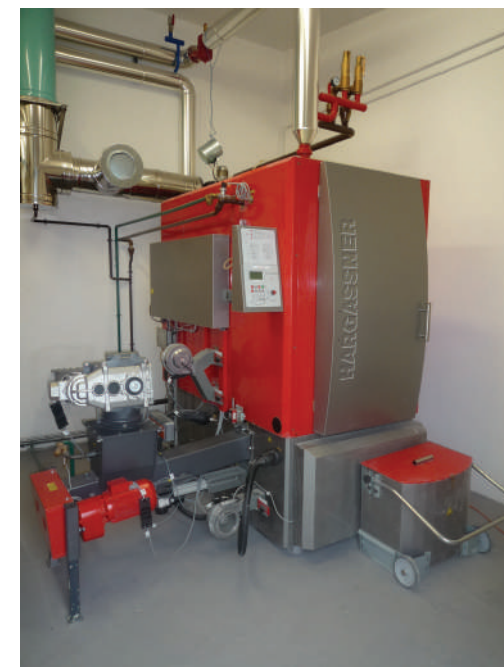
Illustration 2 : Chaudière bois déchiqueté
