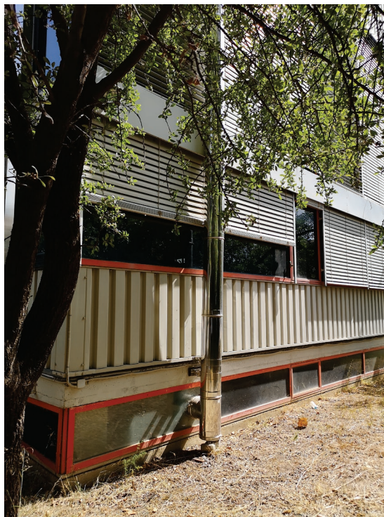
Εικόνα 5: Η όδευση προς το δώμα του απαγωγικού συστήματος του μηχανήματος μόνωσης
