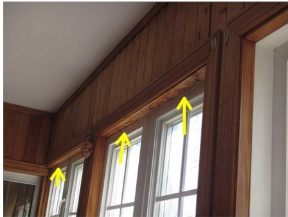
Traces d'infiltration d'eau au haut des fenêtres de la salle à manger
