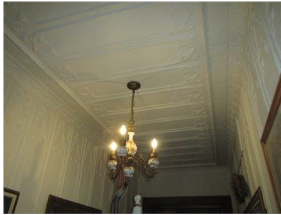
Tôle gaufrée dans le bâtiment d'origine
