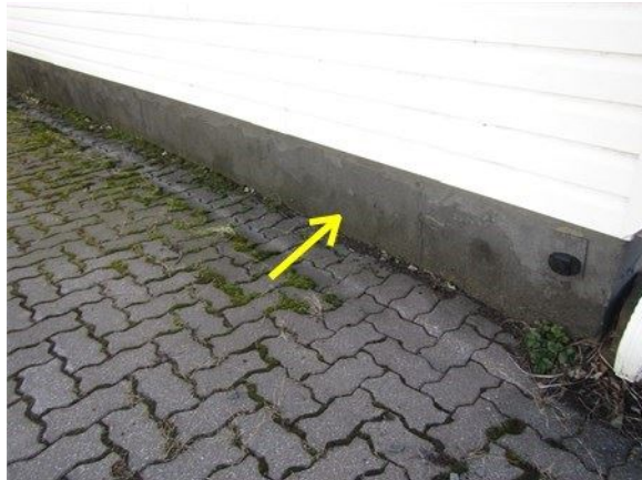
Le mur latéral gauche a été recouvert d'un enduit asphaltique au-dessus du niveau du sol
