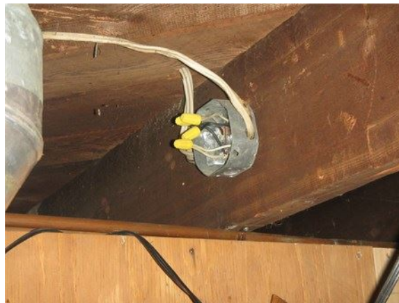
Installez un couvercle sur la boîte de jonction dans le sous-sol
