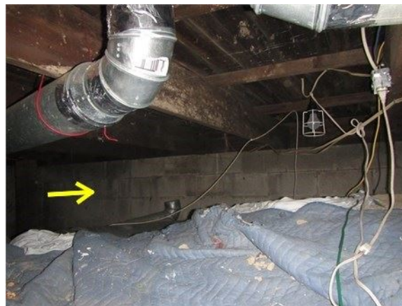
Le mur latéral gauche vu à partir du vide sanitaire
