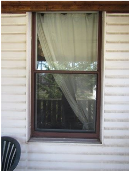
Exemple de vieille fenêtre en aluminium à guillotine
