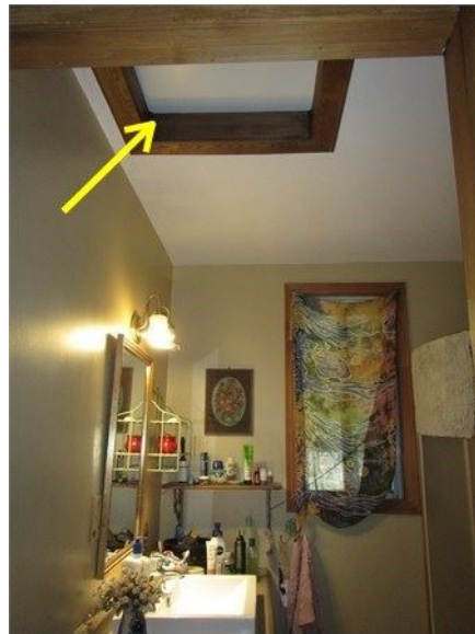
Une des trappes d'accès à l'entretoit dans une salle de bains
