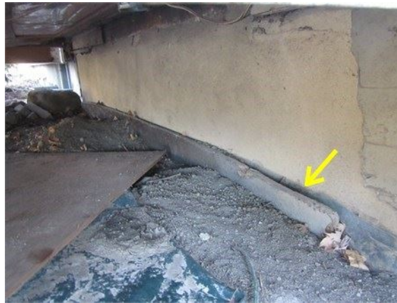
Isolation partielle sous le niveau du sol des murs de fondation
