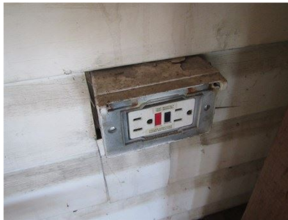
Couvercle brisé à remplacer sur une prise extérieure
