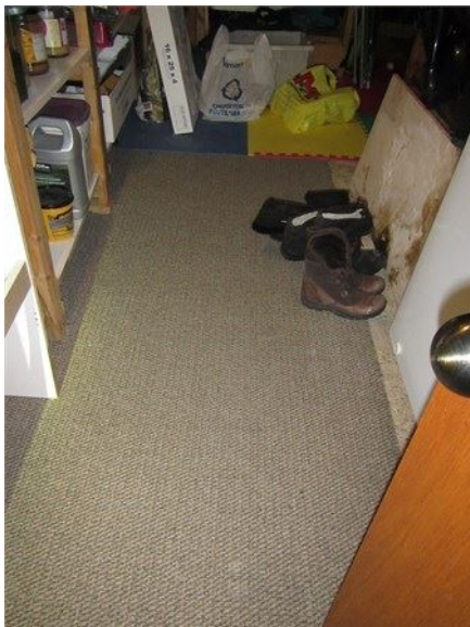
Tapis dans le sous-sol
