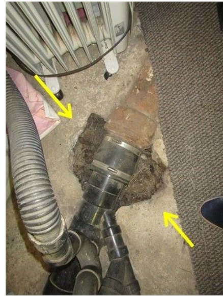
La dalle de béton est ouverte autour du collecteur des égouts
