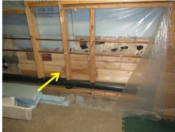
Réparation au bas du mur avant avec coffrage en bois
