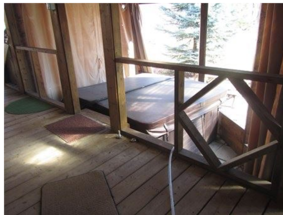
Garde-corps non conformes de part et d'autre du SPA
