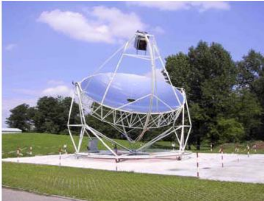
Fig. 1.6 Impianto a disco parabolico
